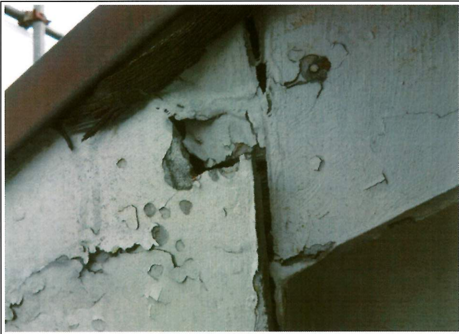
②⑥破風 施工前
