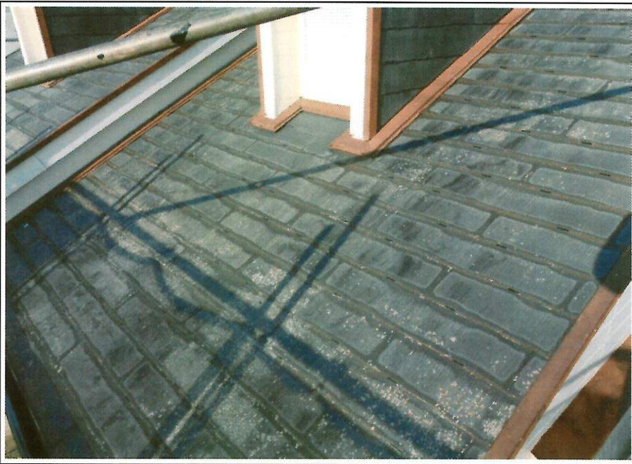
⑩タスペーサー完了
