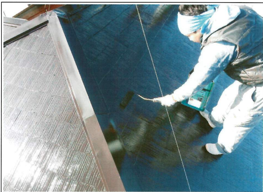
⑩上塗り施工中
