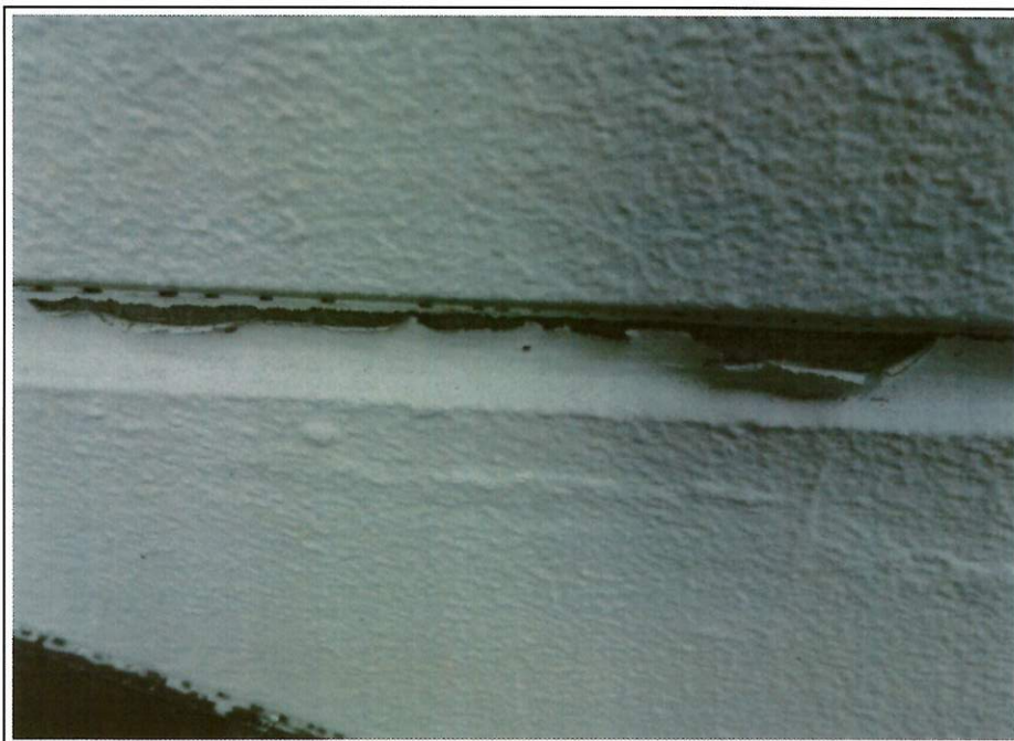
⑦外壁 施工前
