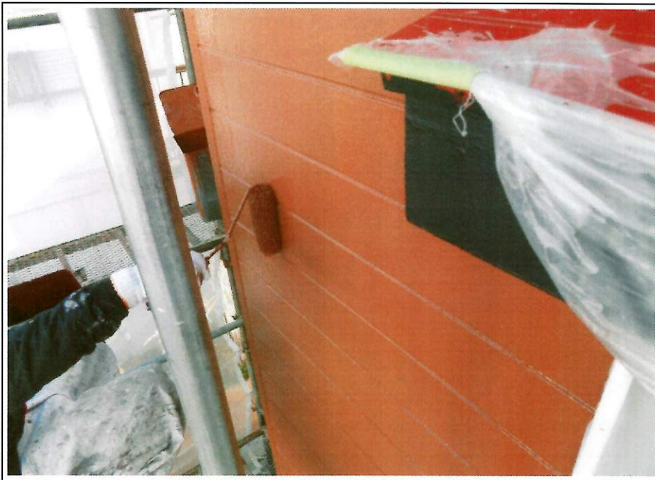
㉒上塗り施工中
