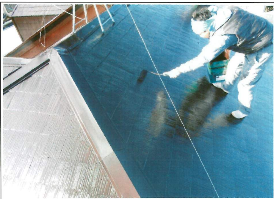
⑫上塗り施工中
