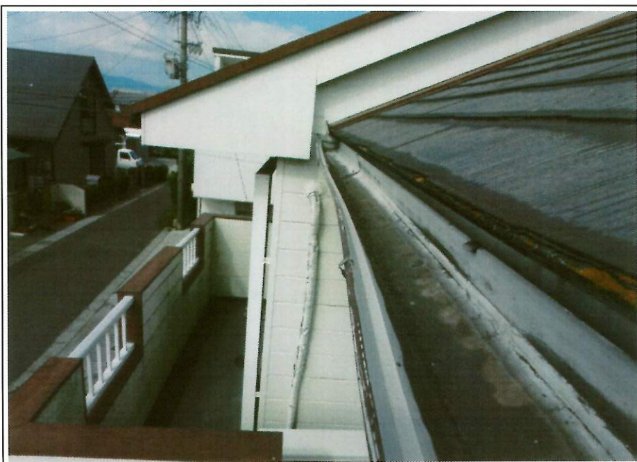
③③樋 施工前
