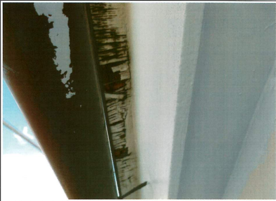
③①軒天 施工前
