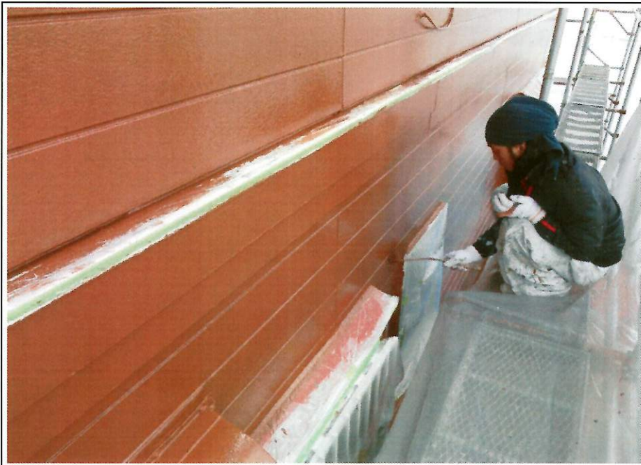
㉓上塗り施工中
