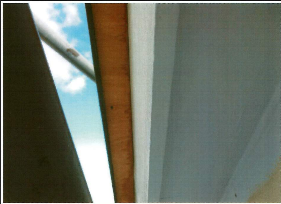
③②軒天 施工後
