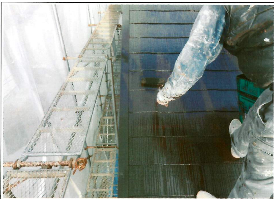
⑪上塗り施工中
