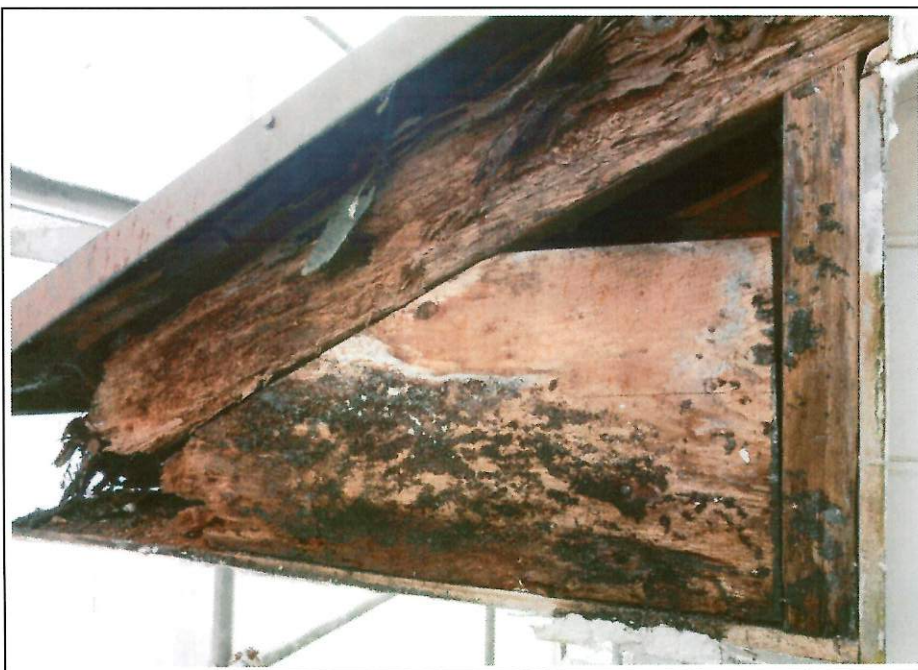
②⑦破風板 撤去
