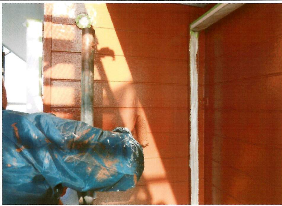
⑳上塗り施工中
