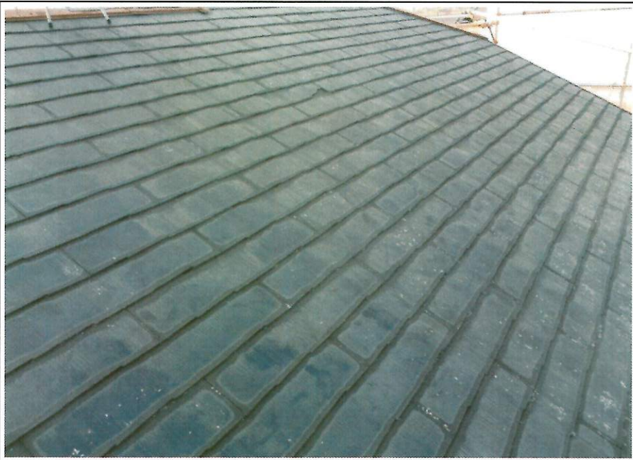
⑪タスペーサー完了
