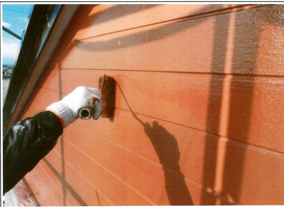
㉑上塗り施工中
