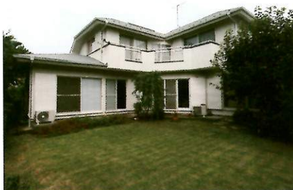
M邸：塗布箇所/屋根：130㎡、外壁：140㎡。
