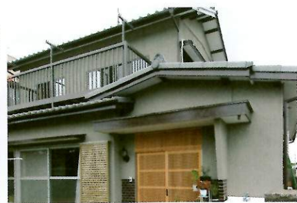
K邸：塗布箇所/内壁・天井：40㎡、外壁：260㎡。
