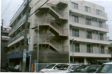
老人ホームの屋上・外壁に塗布。
