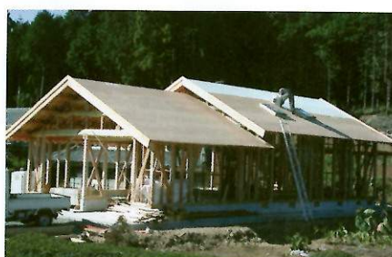
瓦屋根家屋の野地板に塗布。
