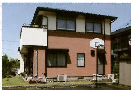
O邸：塗布箇所/屋根：90.9㎡、外壁：156.95㎡。
