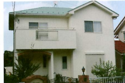
S邸：塗布箇所/屋根：94㎡、外壁：140㎡。
