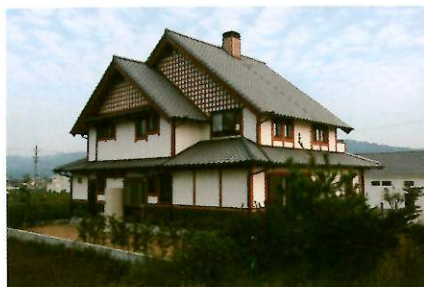
T邸：塗布箇所/屋根：300㎡、外壁：180㎡他。
